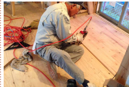
造作工事 後で床鳴りがしないよう、慎重に床板を張っています。
