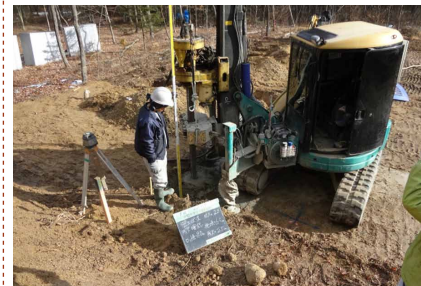
地盤改良 地盤改良工事を行いました。これで地盤は安心です。
