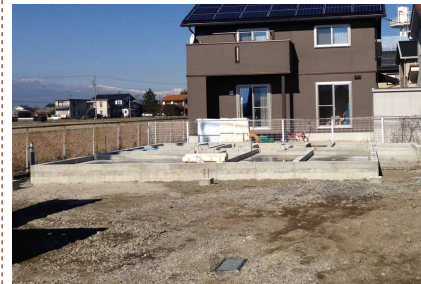
基礎工事 コンクリートを打ちました。
