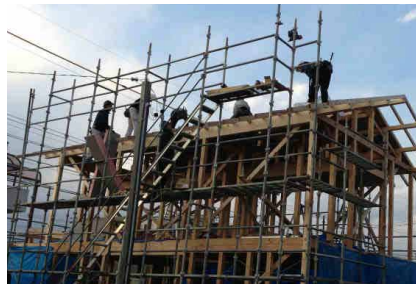
建て方 工事も順調に進みました。
