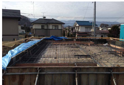
基礎工事 鉄筋組が終わったところです。
