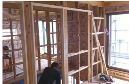
建具枠製作中
